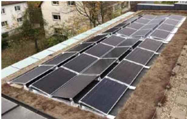
**Abb. 5: Flachdachanlage mit bifazialen Solarmodulen und verschiedenfarbigen Dachfolien**
